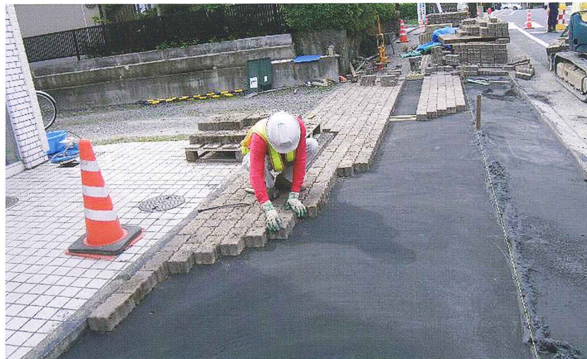
▼ナスサンドをインターロッキングの敷砂として使用した現場
