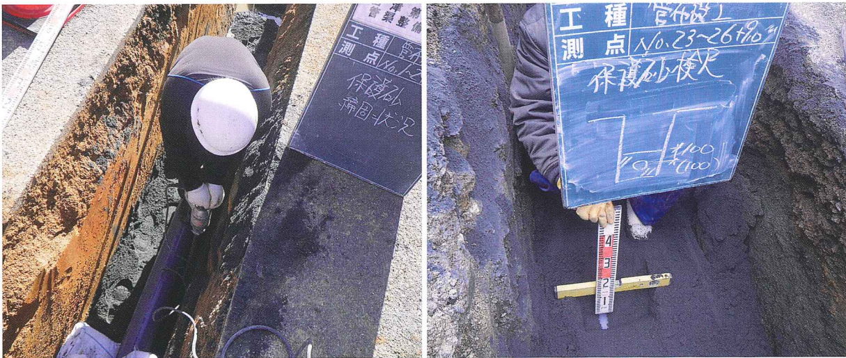
▼ナスサンドをインターロッキングの敷砂として使用した現場
