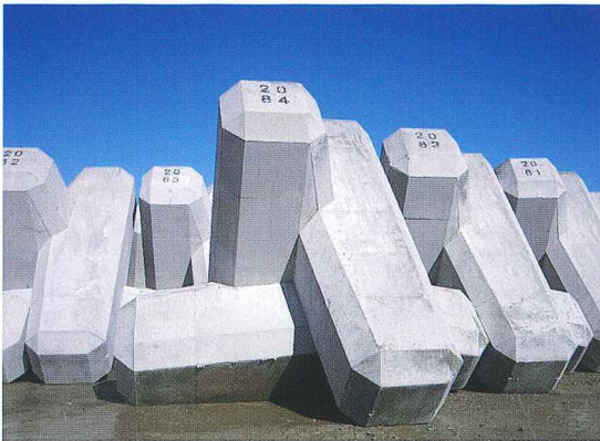
◀ナスサンドを使用した生コンで製作された 70t消波ブロック
