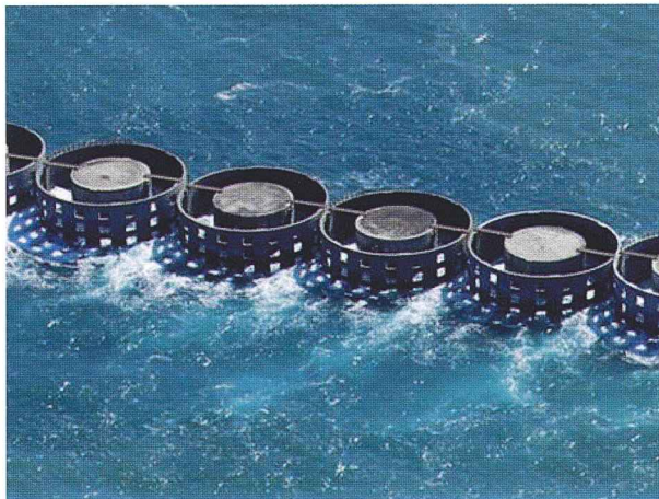
▼ナスサンドが中詰め材として使用されたケーソン
